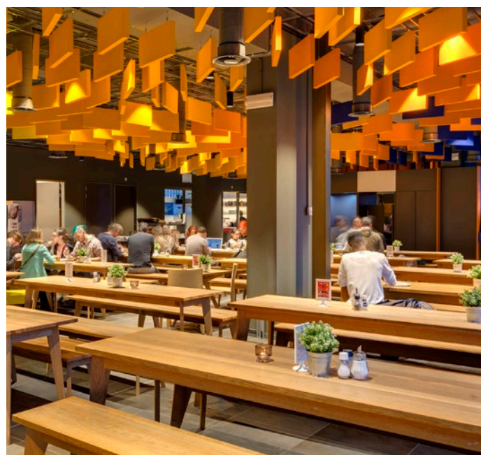
Projekt: Meininger Hotel, Amsterdam, Holland / Arkitekter: Christian Sandor Tschersich, LAVA Architecture / Undertakslösning: Rockfon Contour® / Baffel Bärverk: Chicago Metallic™ T24 Hook 2850 / Foto: Meininger Hotel, Amsterdam, Holland
